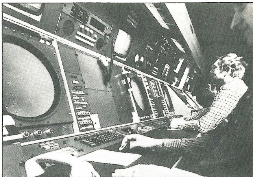
Mesa de controle do Sistema de Comando de Tráfego Aéreo — TERCAS
