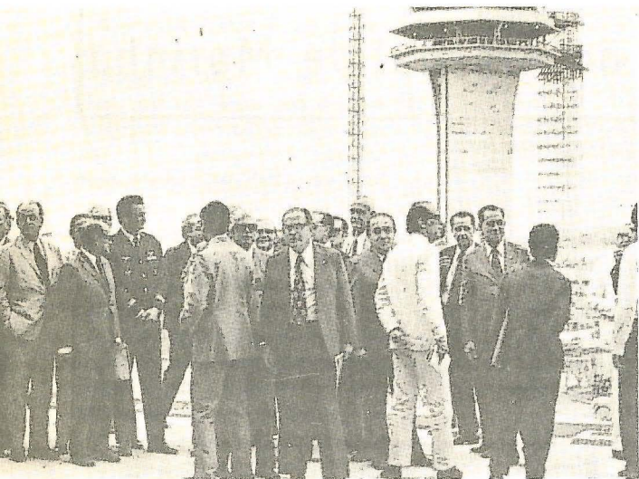
A Comitiva chega às obras do Novo Aeroporto.
