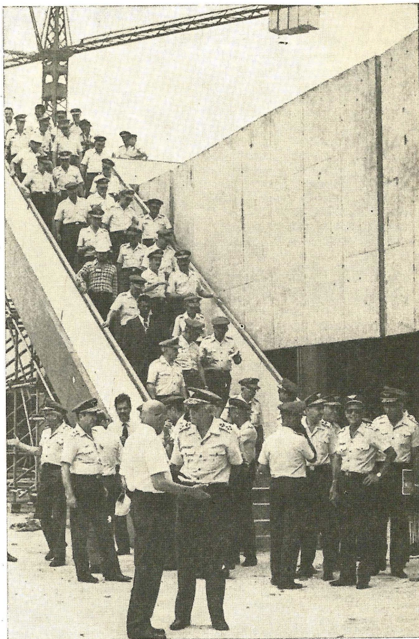
O Ministro Araripe Macedo com os Brigadeiros nas obras do novo Aeroporto
