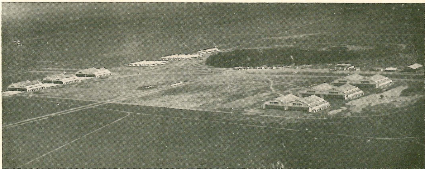
Aspecto dos seis hangares já prontos e dos pavilhões cujas construções estão sendo ultimadas, para abrigar breve os aviões e alunos da Escola de Aeronáutica
