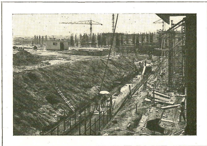
A construção de galerias subterrâneas.
