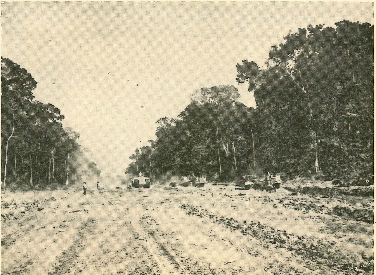
Trabalho de terraplenagem da Estrada Pôrto Velho - Guajará-Mirim
