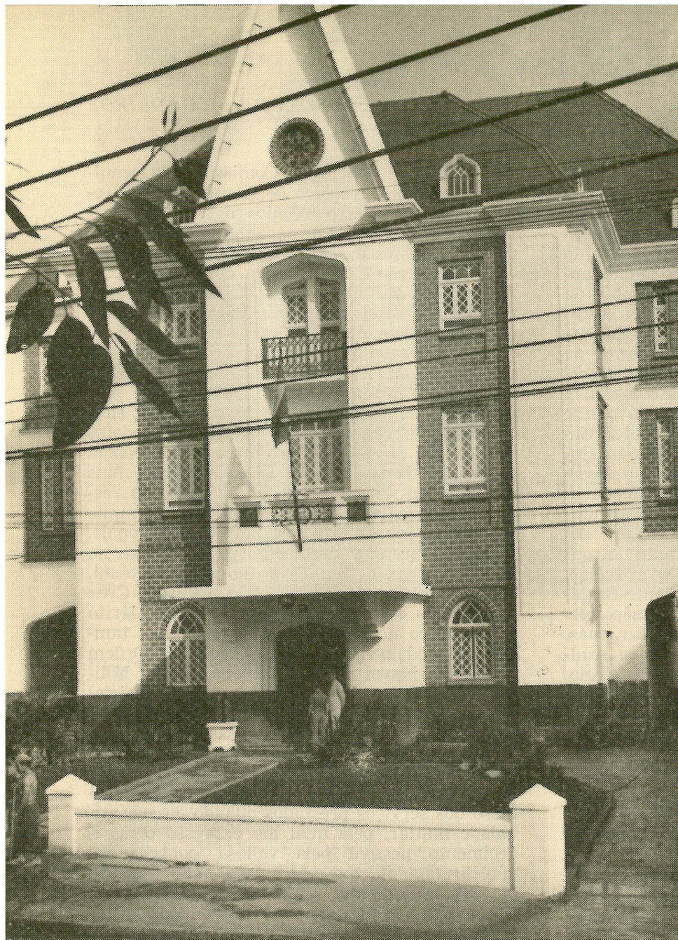
Edifício-Sede da Comissão Nacional de Energia Nuclear, no Rio de Janeiro
