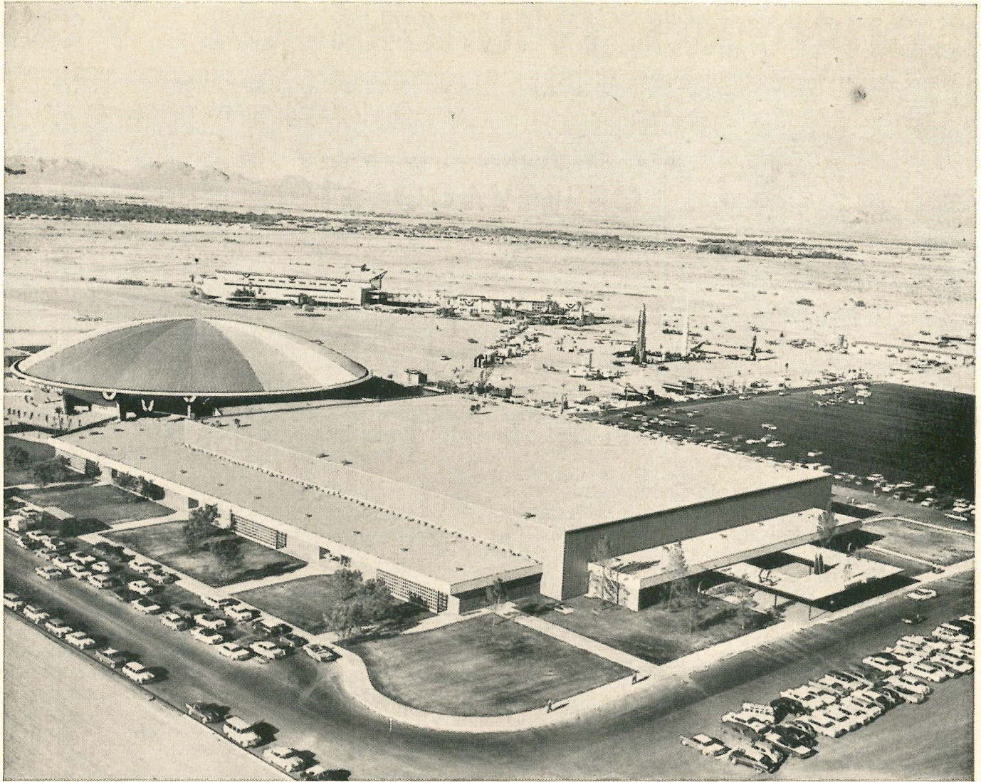
O Conjunto das edificações do "Convention Center" de Las Vegas, vendo-se a área retangular de 10 000 m 2 , onde se realizam as exposições, e a redonda, compreendendo o Salão de Conferências e tôdas as instalações.
