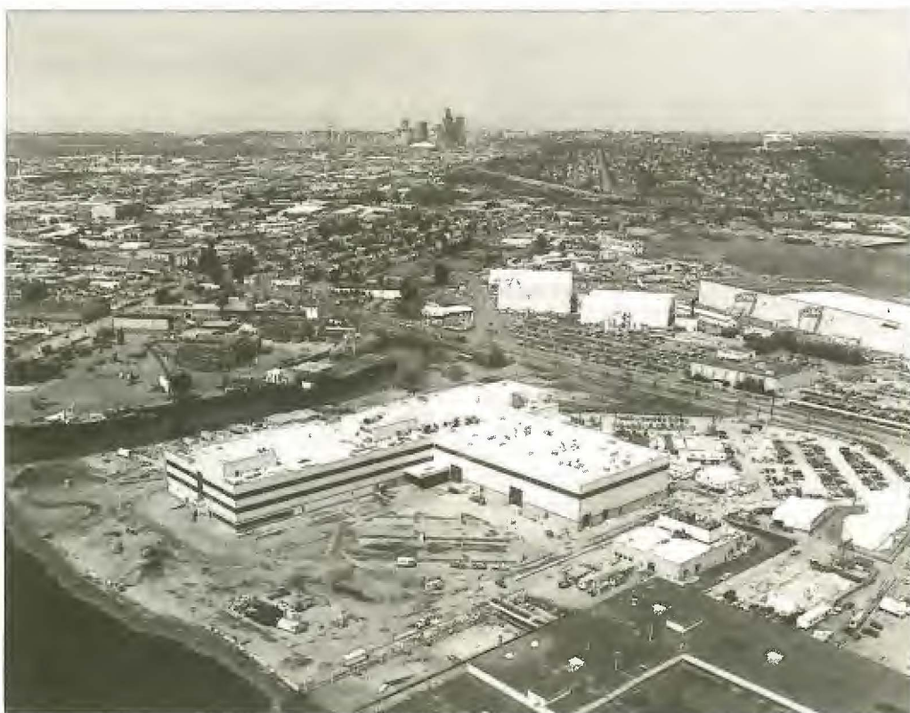
O novo Laboratório Integrado de Sistemas Aeronáuticos da Boeing que possui 48.000m 2 de área - o equivalente a 100 vezes a área ocupada por um superjumbo
