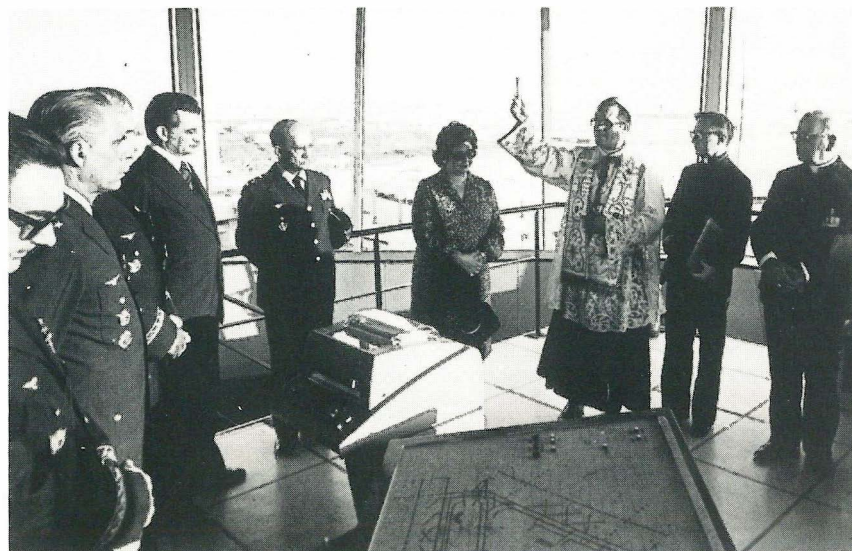
Em 1977, antes de entrar em operação, a Torre de Controle do Aeroporto Internacional Rio foi benzoado pelo Bispo Auxiliar do Rio; na foto ao fundo Brig Pires.
