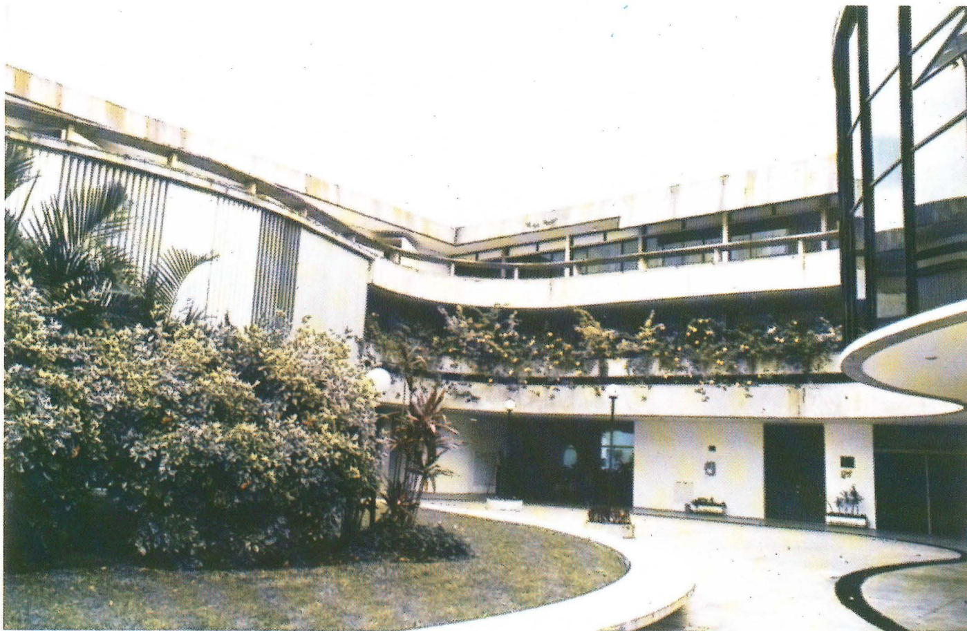
Aspectos das dependências da Sede Social, vendo-se nos pavimentos superiores o moderno hotel de trânsito
