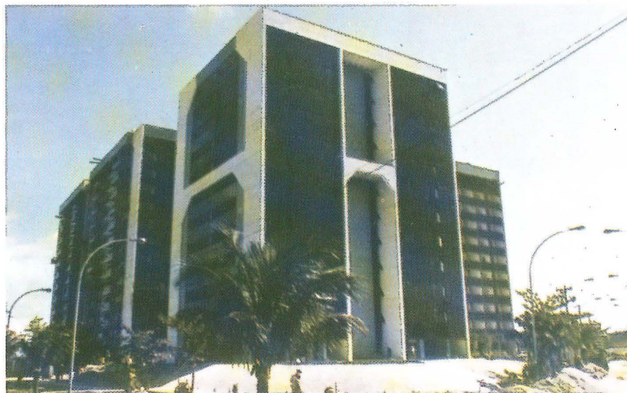
O Condomínio Mandala, na Av. das Américas, obra da CHICAER
