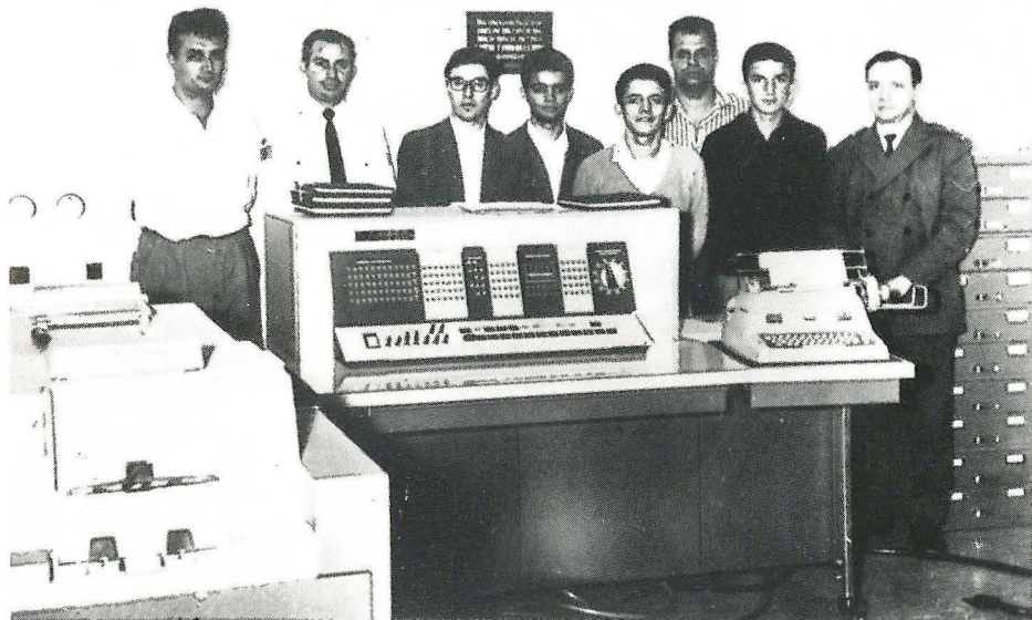
Grupo pioneiro que instalou o 1º computador científico no Ministério da Aeronáutica, no ITA (1963). Ao lado, a velha máquina 1620, cuja capacidade computacional, hoje, pode ser inserida em uma pastilha ("chip") que cabe na mão de uma criança.
