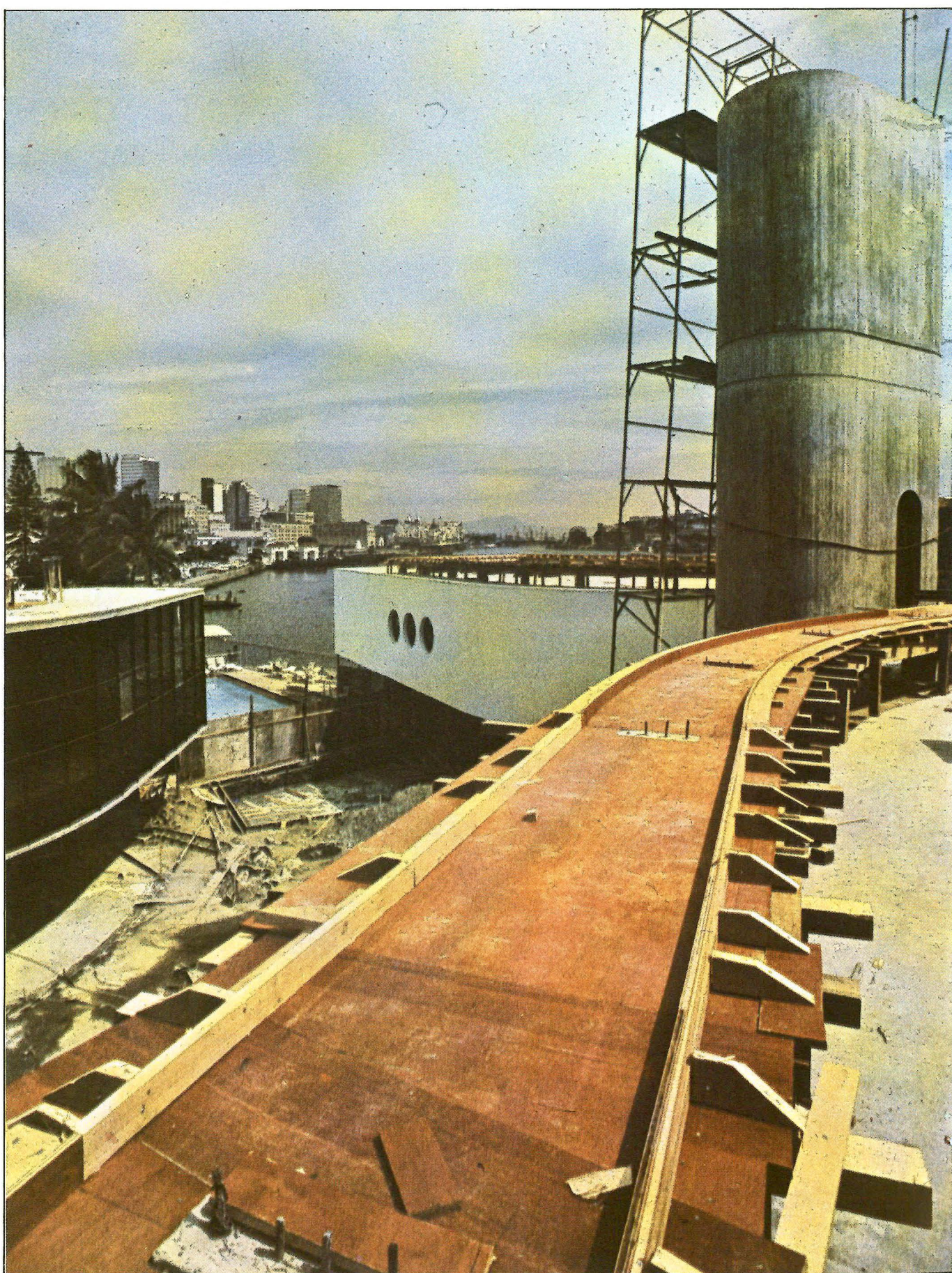
Obras, em fase de conclusão, da futura Sede Social.
