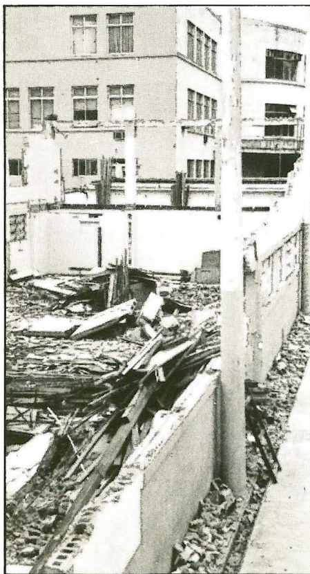
Parte já demolida, onde funcionava a administração, na Sede Desportiva
