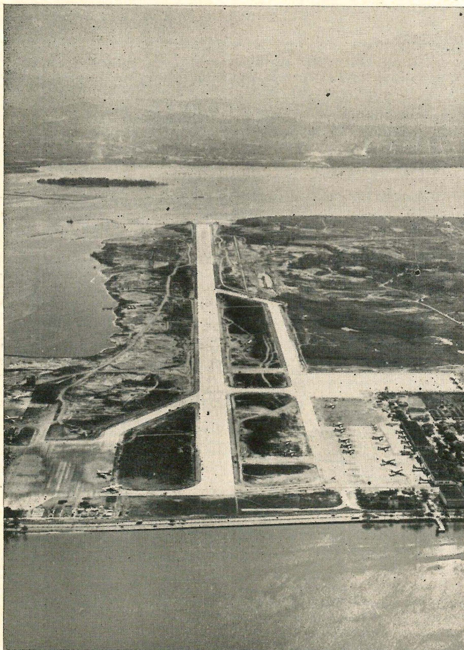
Vista de conjunto do Aeroporto do Galeão, mostrando a nova pista com 3 182 metros já concluídos e os pátios da Estação de Passageiros e da Base Aérea do Galeão
