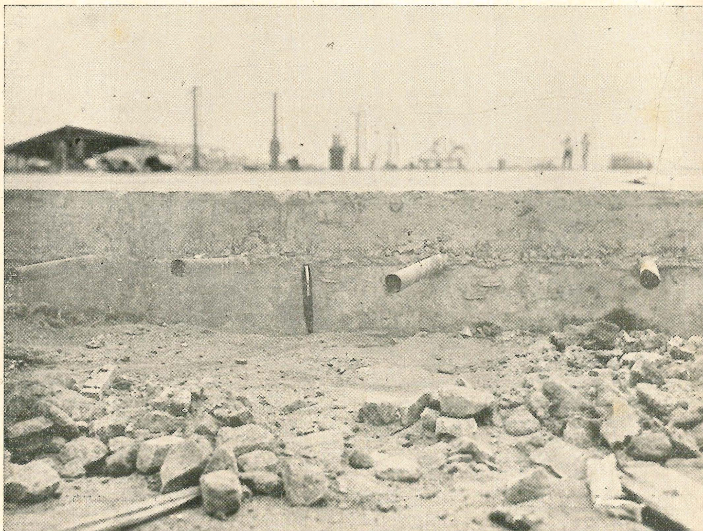
Detalhe do pavimento de concreto de cimento da pista do Galeão, mostrando a altura do pavimento — 29 cm — e a armadura da junta de construção
