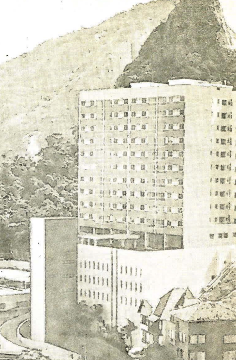
Edifício à R. Mascarenhas de Moraes, 191
