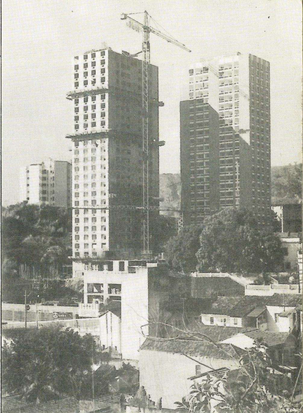
Obra à Rua Mário Portela 161, Laranjeiras — a ser entregue pronta em meados de 1977.
