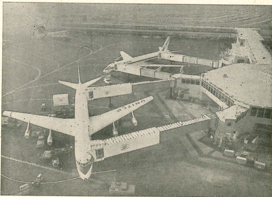
Dois aviões DC-8 "Jet- Mainliners" prontos para receber seus passageiros através dos corredores de embarque para jatos no Aeroporto Internacional de São Francisco. As unidades foram projetadas para proteger os passageiros, quando embarcam ou desembarcam, contra as inclemências do tempo, e eliminar o tráfego no pátio de manobras.
