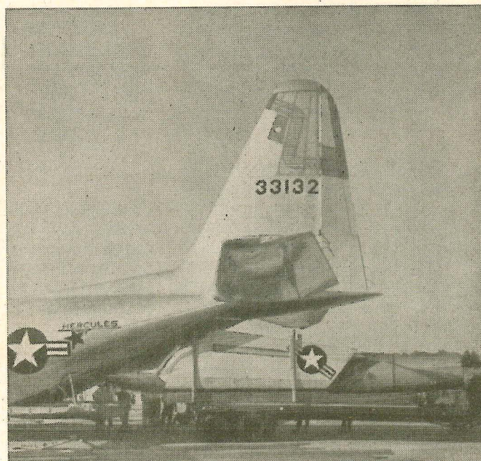
A espaçosa porta traseira de carregamento do C-130-A (esquerda) facilita um fácil carregamento do míssil tático, Martin TM-61, Matador
