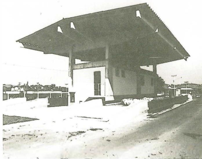
*Duas balanças para a pesagem do lixo na entrada da USINA. Cada uma tem capacidade para 60 toneladas*
