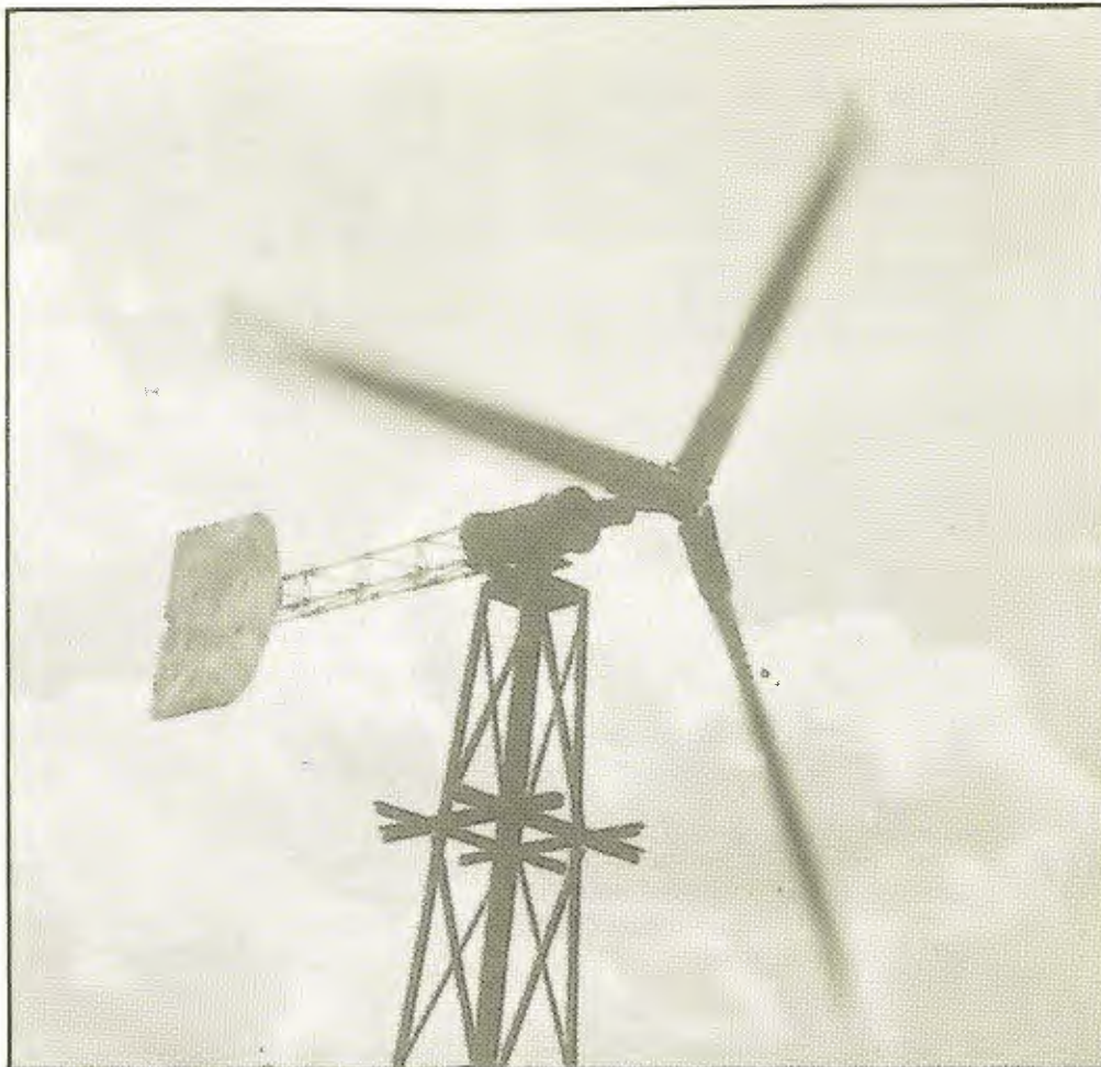
Um gerador eólico de pequena escala (4 KVA), também construído no CTA, e instalado sobre um prédio do IAE
