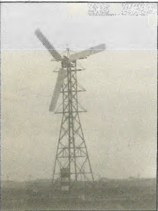
← Protótipo de gerador eólico para 30 KVA, construído pelo IAE e instalado no Campus do CTA
