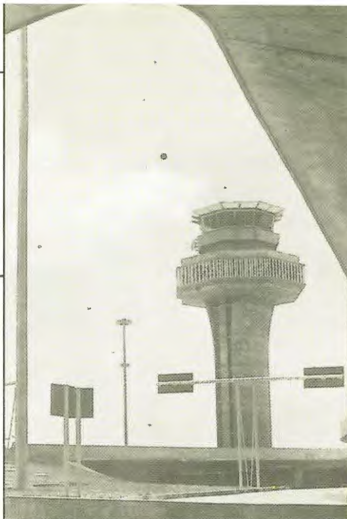
Torre de Controle do AIRJ
